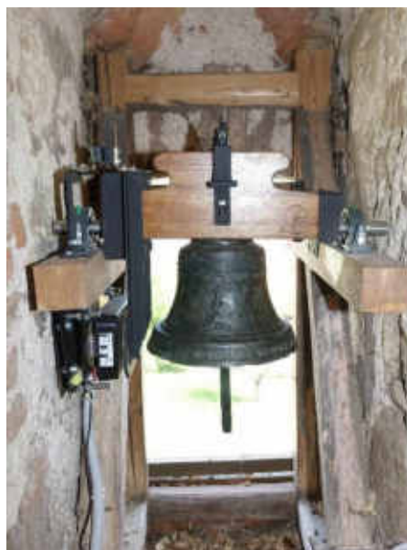
Zavěšení zvonu ve věži kostela
