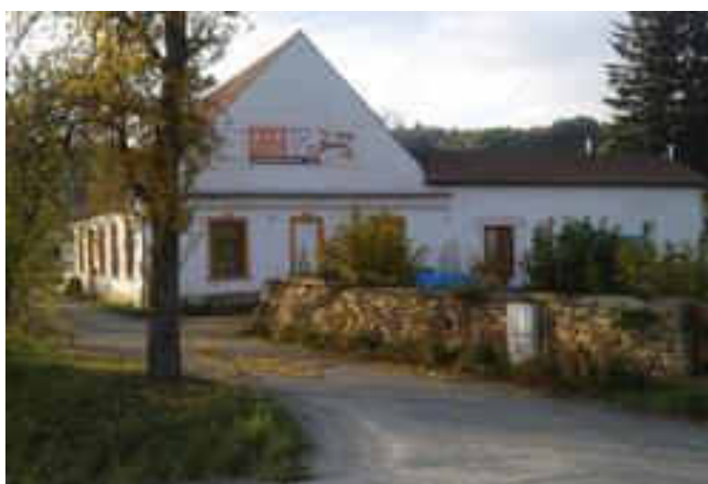
Klemov – bývalá Jeřábekova hospoda – současné sídlo firmy M & M
