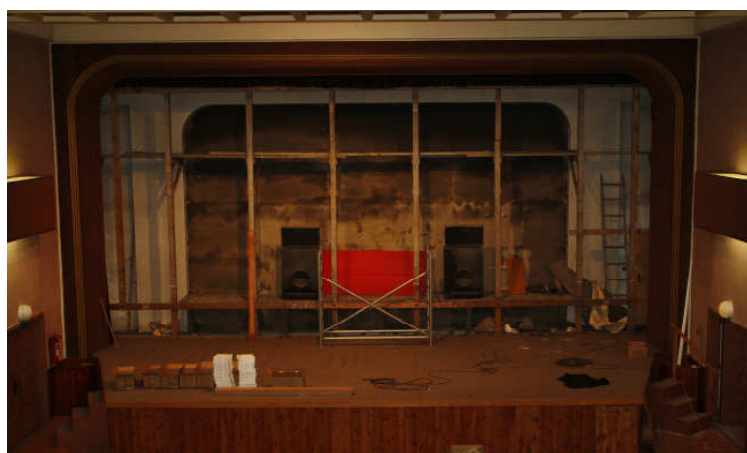
22. dubna 2013 – původní promítací plátno je sneseno, připravuje se kostra pro zavěšení nového plátna
